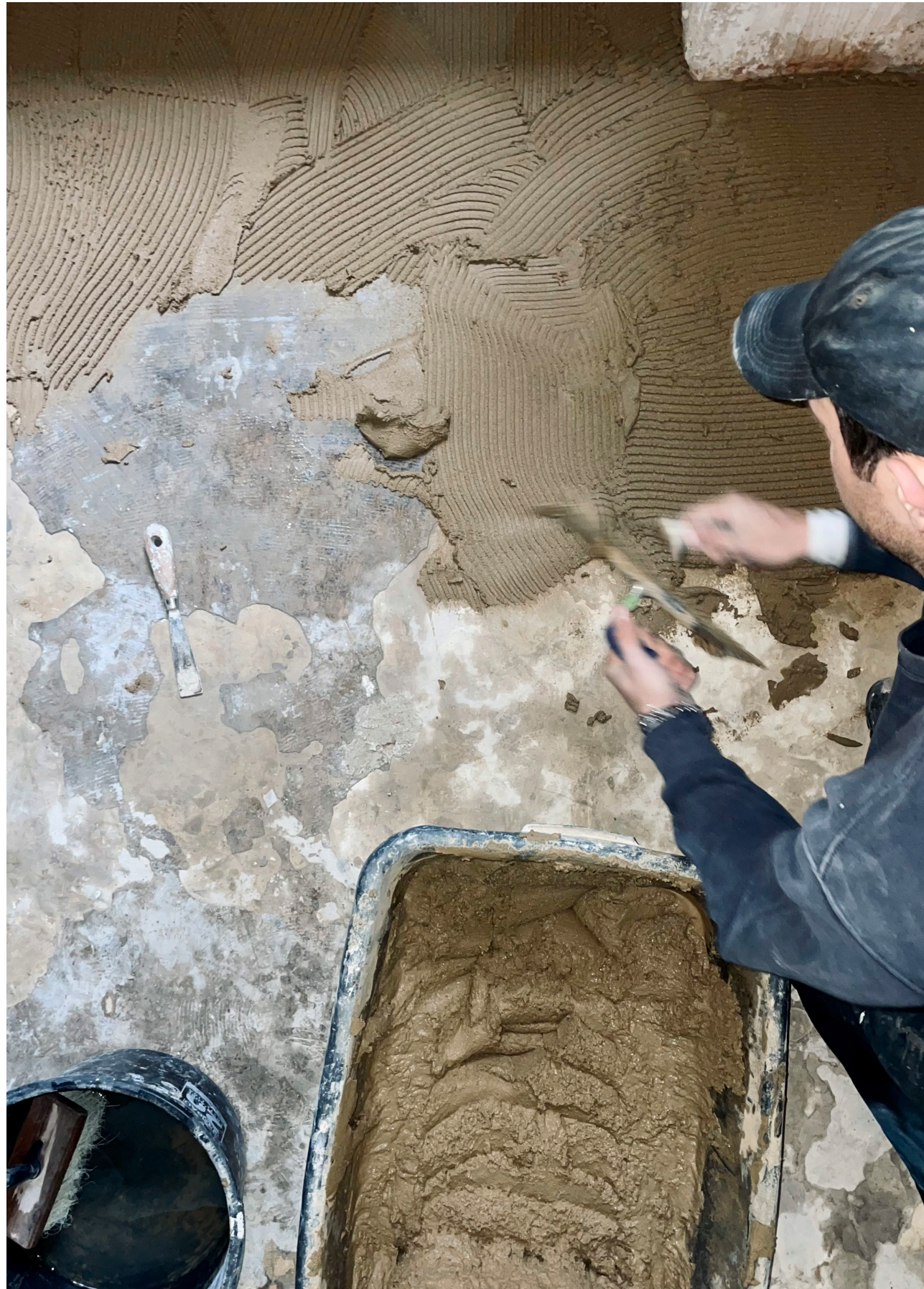
Forschung vor Ort: Herstellung des Lehmbodens
