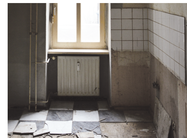
Ehemalige Küche vor der Sanierung
